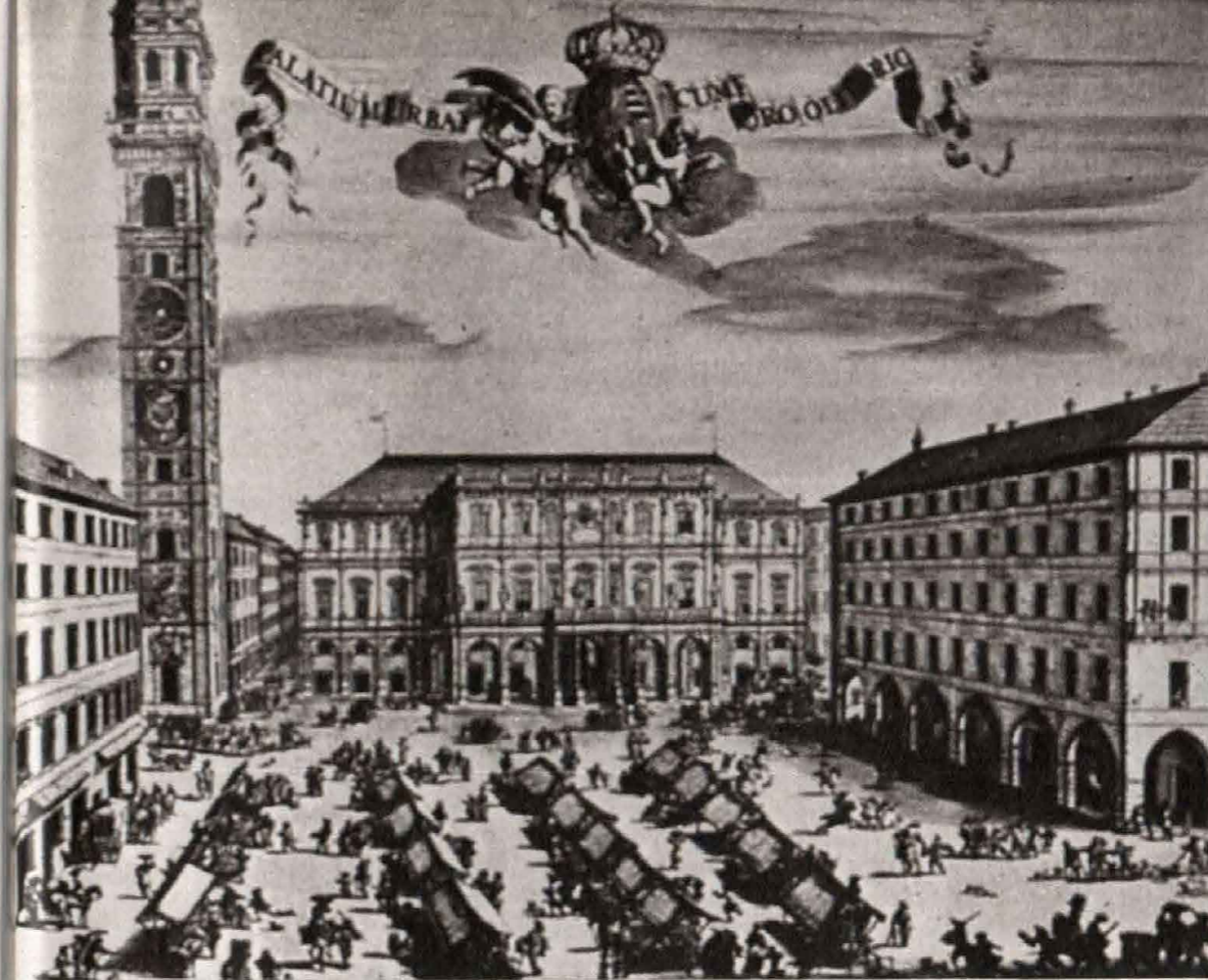
Torino, Palazzo di Città, XVII secolo. Alla fine del 1600, col calar della sera, due grandi torce venivano accese alla porta del Palazzo di Città, opera dell'architetto Carlo Emanuele Lanfranchi, mentre il campanone maggiore dell'attigua Torre dava il suono dell'«Ave Maria»; poi le porte della città si chiudevano sino al suono dell'«Angelus» del mattino successivo.
