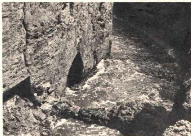
Quel che resta delle due sezioni di roccia tagliate dagli Etruschi per l'uscita in mare delle acque del canale. Questo canale di deflusso, costruito dagli antichi Etruschi per il lago di Burano, funziona tuttora e funziona benissimo.
